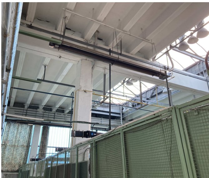
Obrázek 5 – plynové zářiče v dílenské hale
