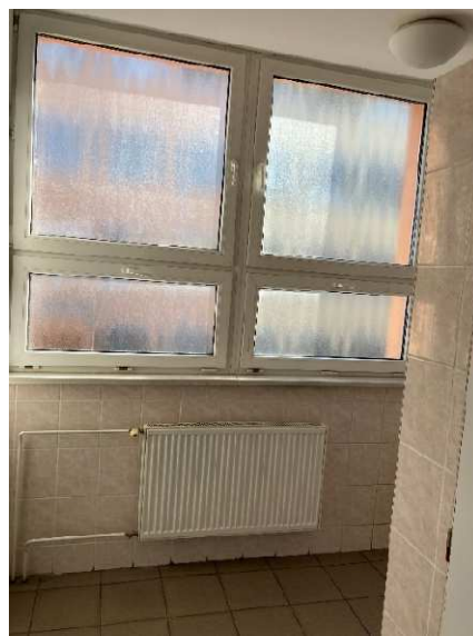
Obrázek 6 – deskové radiátory v přístavbě
